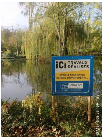
Aménagement terrain de loisir et de détente de Saint-Rimay
